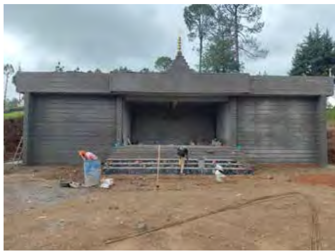
गांव में निर्माणाधीन रामलीला भवन
